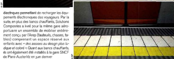
La rampe réalisée par Solutions Composites permet non seulement un accès de plain-pied dans les rampes mais offre aussi plus de sécurité pour les malvoyants, (ici à la station Invalides du RER C)
