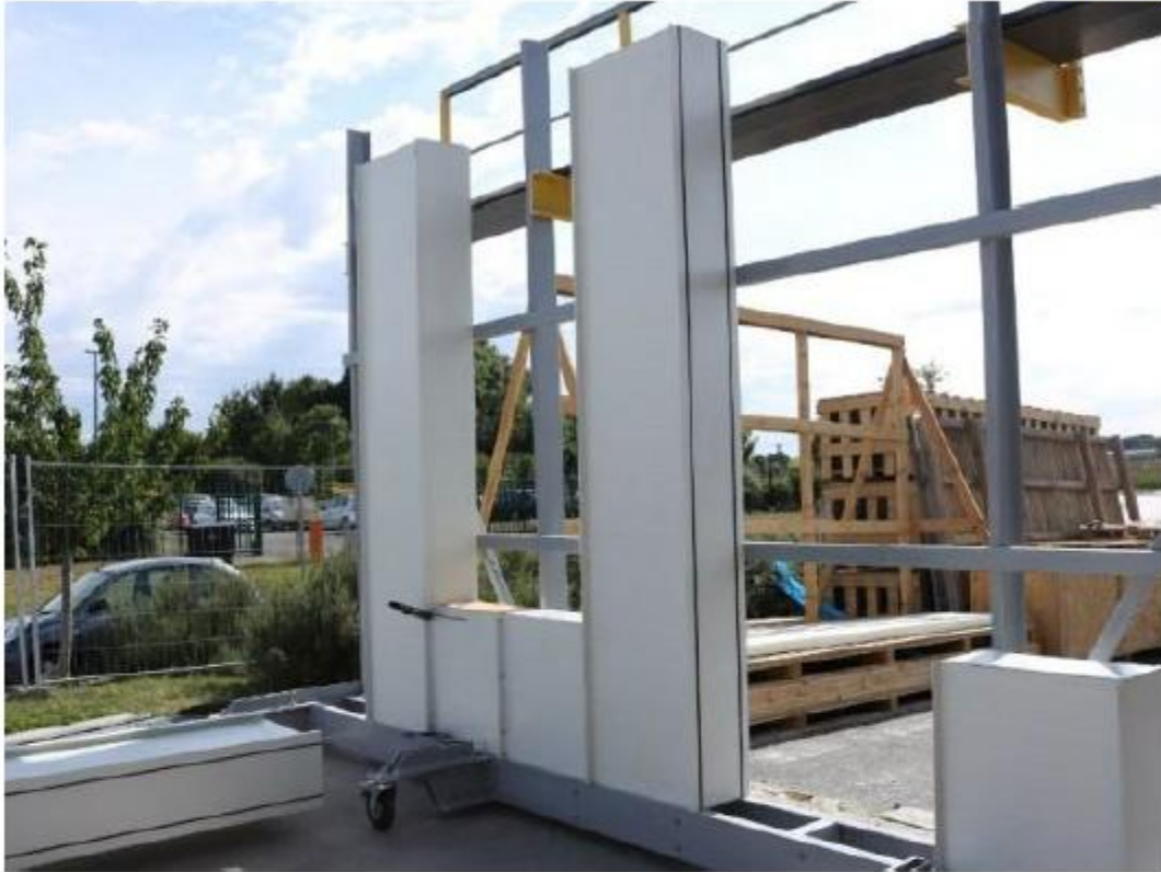
Système constructif avec matériaux composite © Solutions Composites
