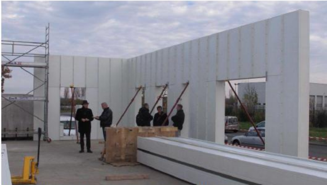
Les murs préfabriqués de la « CompoHouse » sont en cours de montage.
